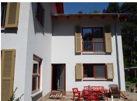
Wohnhaus in Lehnitz, 2010
